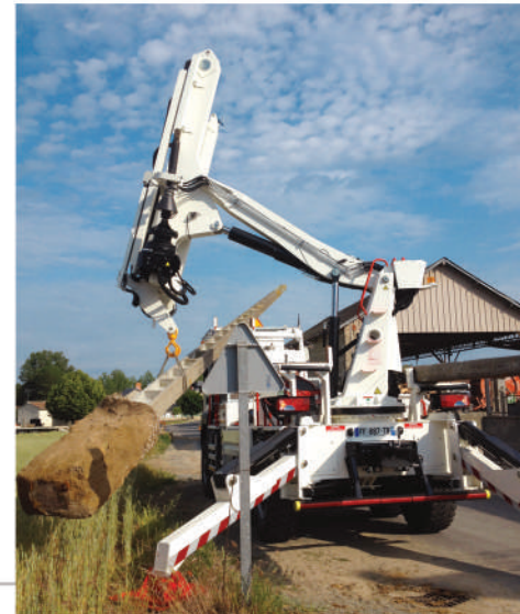
Kran 100TA30 Stabilisierung ein A
