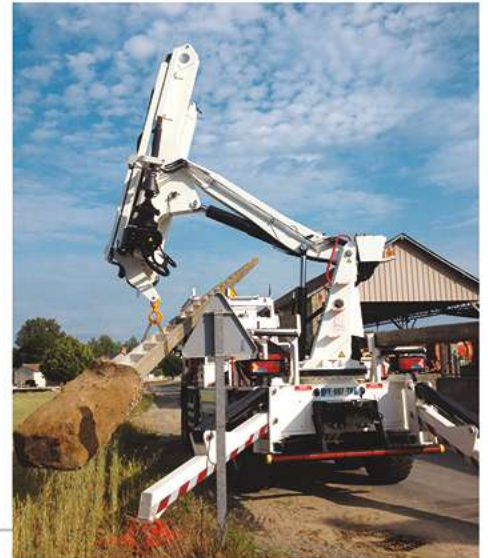
Kran 100TA30 Stabilisierung ein A
