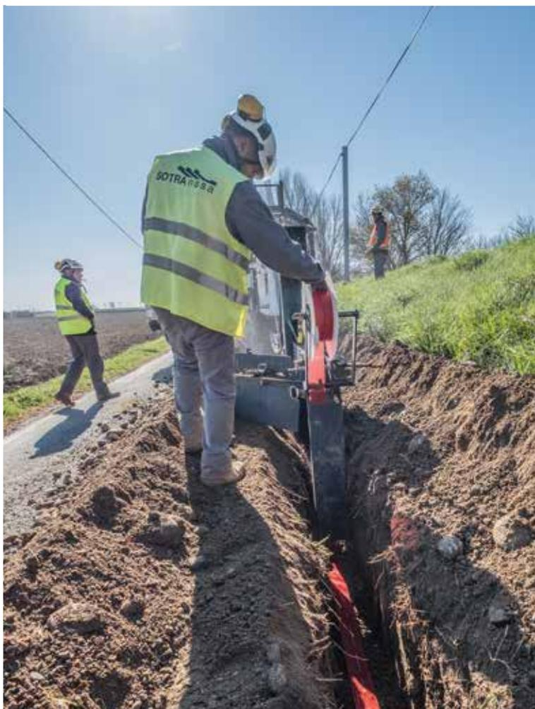
*Ci-dessus* : Opération de pose mécanisée, avec enfouissement des câbles par un caisson de pose et remblayeur hydraulique. Le grillage avertisseur est également déroulé à l'avancement
