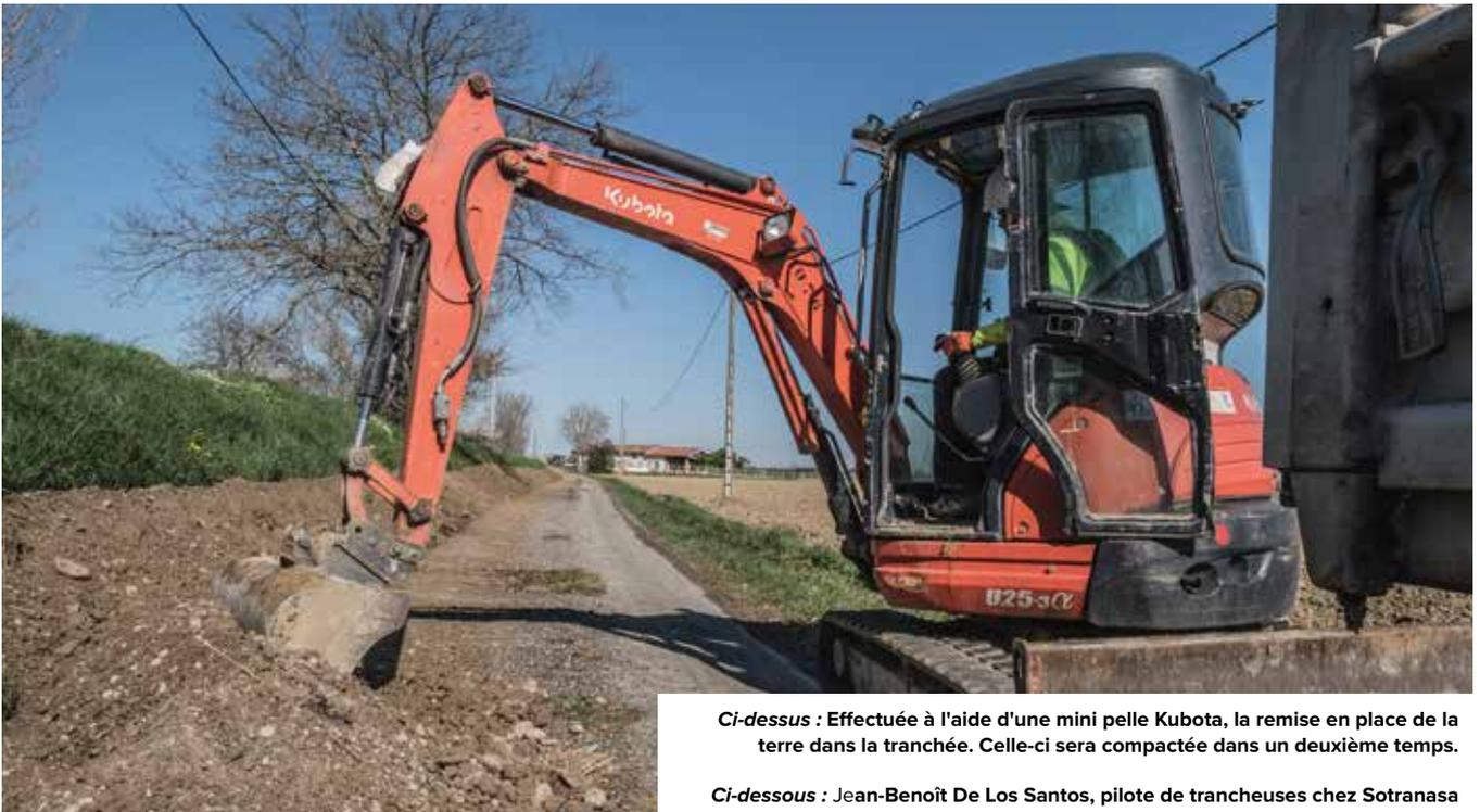
Ci-dessus : Effectuée à l'aide d'une mini pelle Kubota, la remise en place de la terre dans la tranchée. Celle-ci sera compactée dans un deuxième temps.
