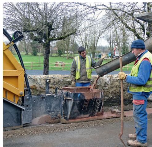
Une fois que la trancheuse a fendu le sol et y a déposé le fourreau, Chassaing TP peut recouvrir par du sable ou du béton autoplaçant généralement coloré.
